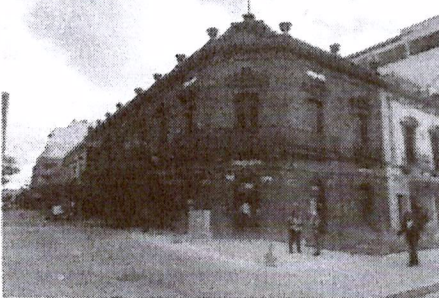
FACHADA PRINCIPAL 16 DE SEPTIEMBRE
